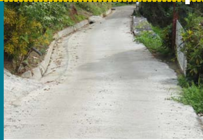
Réalisation d'un talus à Chemin Raisin (Route reliant Raisin à Pontaléry)
